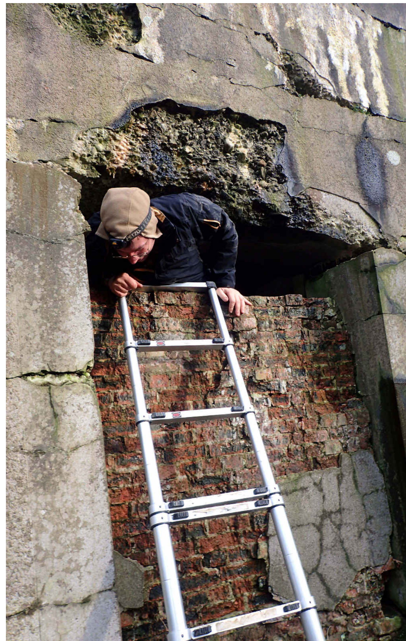
Klimwerk in enkele ruimtes in het fort van Broechem te geraken - Margaux Boeraeve
